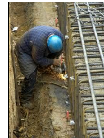
Photo 11 : Préparation des fondations
