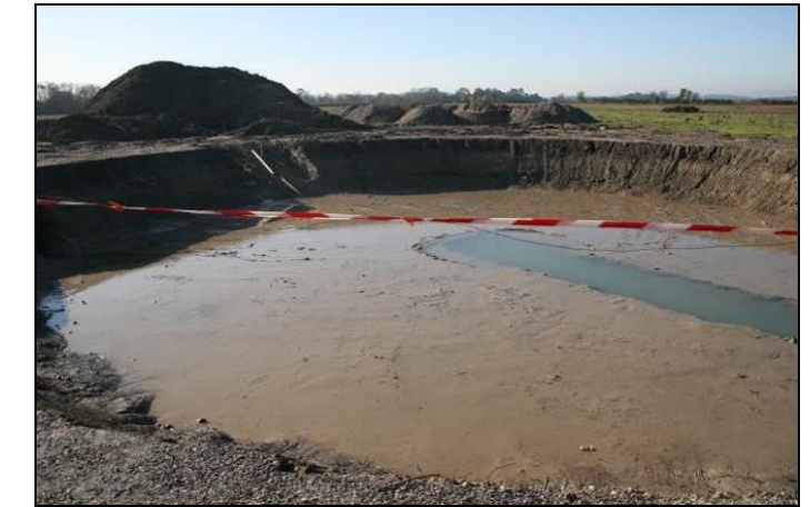
Photo 9 : Fouille de la fondation
