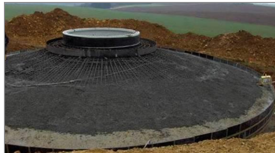
Photo 1 : Exemple de ferrailage en radier pour une éolienne
