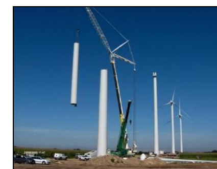
Photo 18 : Vue d'ensemble des étapes d'assemblage de la tour (exemple de tour en acier)
