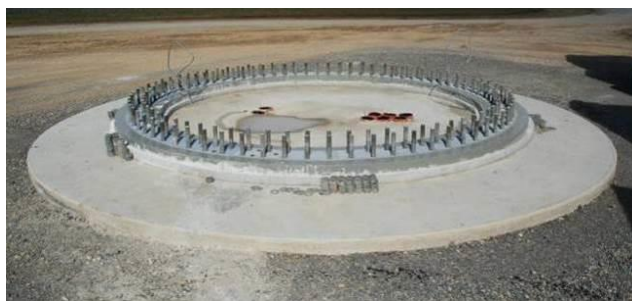
Photo 2 : La fondation terminée
