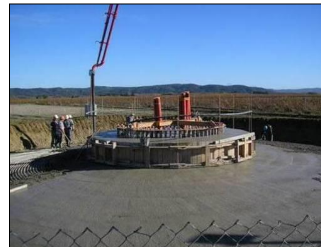
Photo 13 : Coulage du béton
