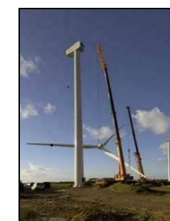
Photo 20 : Hisse et assemblage du rotor
