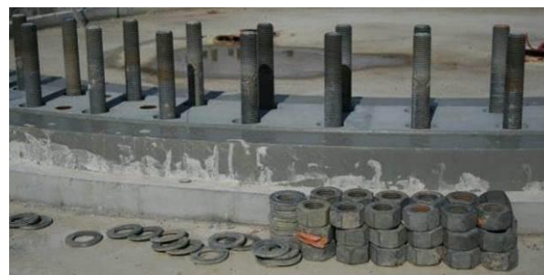
Photo 3 : Détail des fixations de la fondation
