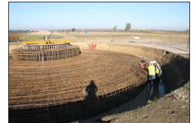
Photo 12 : Ferrailage de la fondation
