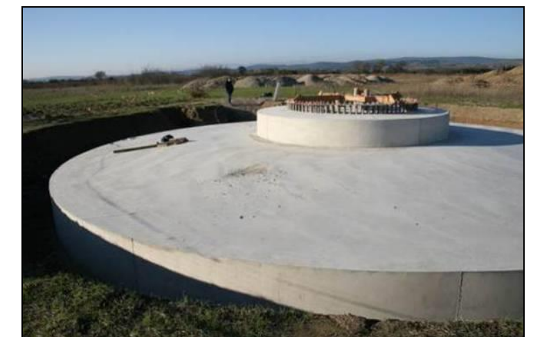
Photo 14 : La fondation terminée
