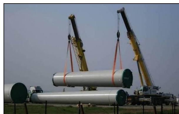
Photo 16 : Manipulation des tronçons d'éoliennes
