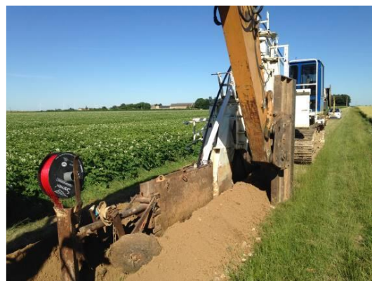
Photo 7 : Engin utilisé pour le creusement de la tranchée et la pose des câbles
