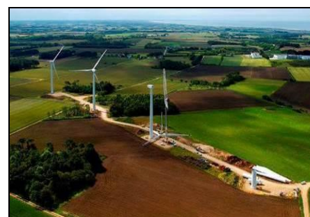
Photo 20 : Hisse et assemblage du rotor
